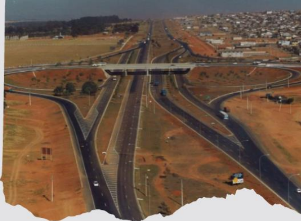
Viaduto na DF-075 (EPNB) na década de 1990
