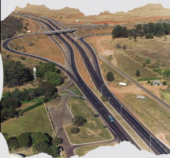
Viaduto do Catetinho na década de 1990
